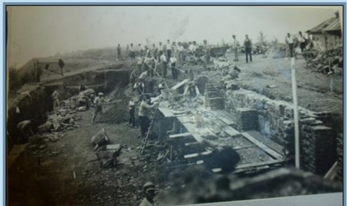
Bau der Hallen, Blick von der südlichen Richtung zum heutigen Klosterwäldchen
