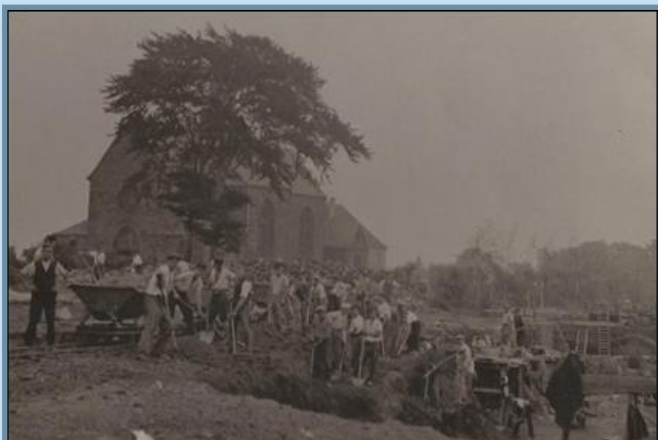
Bau der Hallen – Blick zur Kirche
